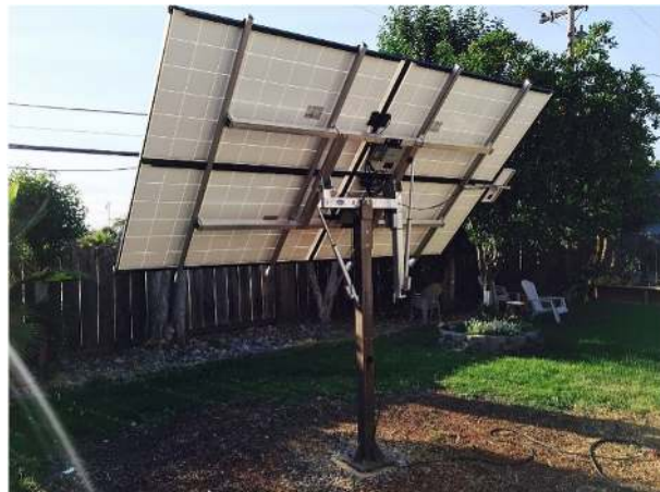
圖 2 裝有跟蹤器的太陽能板（圖片來自互聯網）
