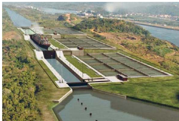
图-2 巴拿马运河扩建带侧池船闸概念图 (图片来自互联网)
