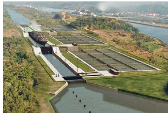
圖-2 巴拿馬運河擴建帶側池船閘概念圖（圖片來自互聯網）
