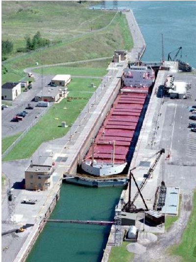
圖 1 紐約馬賽那的艾森豪船閘（簡單船閘） （圖片來自互聯網 1 ）
